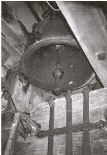
Hier auf dem linken Foto kann man sogar erkennen, warum ab und zu ein Drehen der Glocken nötig ist: Die hellen Flecken im Glockenmantelinnern sind Einbuchtungen, die durch das viele Schlagen der Glocke entstehen, und das, obwohl die Glocke aus massivstem Gusseisen besteht!
